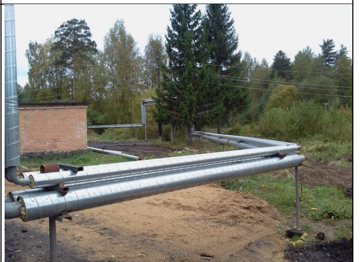
Рисунок 1.2.4 – Вывод теплосети с котельной
